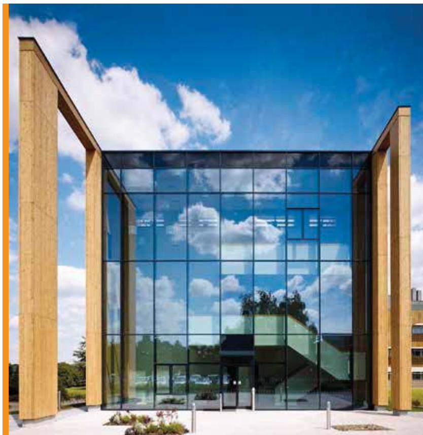
Obr. 1 „Gateway Building“ jedného z kampusov Nottinghamskej univerzity je zo slamou izolovaných prefabrikátov na výšku 4 podlaží, foto: Make Ltd.
