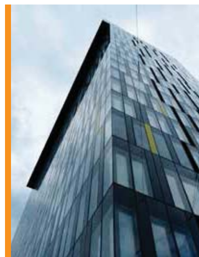
Obr. 5 Budova „PowerTower“ v Linci má štvorité zasklenie
