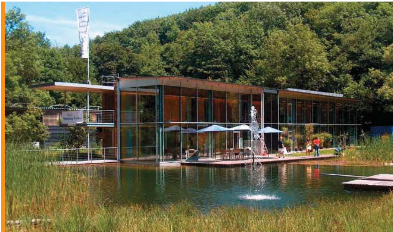
Obr. 6 Pre sídlo firmy Biotop sú charakteristické masívne hlinené steny za zasklenou pavlačou, kancelárie sú obrátené na sever
